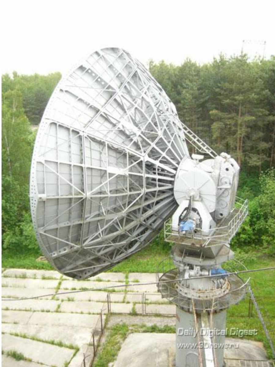
Огромные антенны стоят без дела в частично рабочем состоянии - пока слишком дорогая эксплуатация. Поэтому - тихо покрываются ржавчиной.
