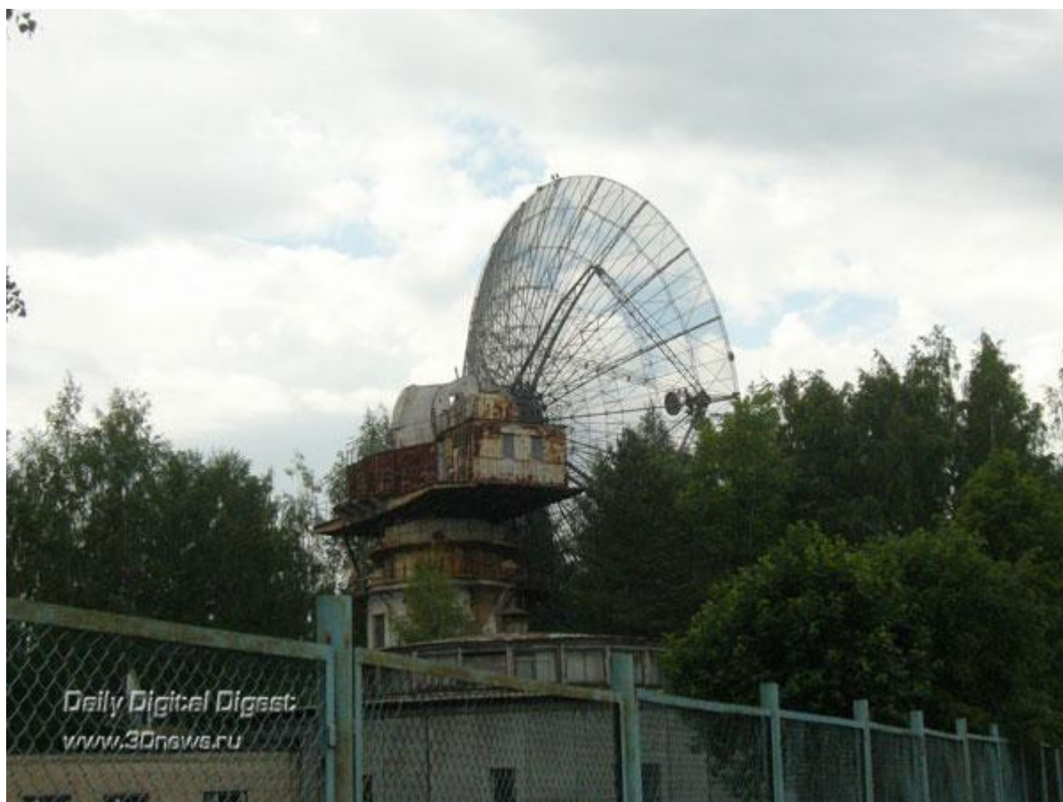
Антенна ТНА-57 (12 метров) - именно она с 1970 года использовалась для прямой правительственной связи СССР-США, работавшей в течение многих лет.
