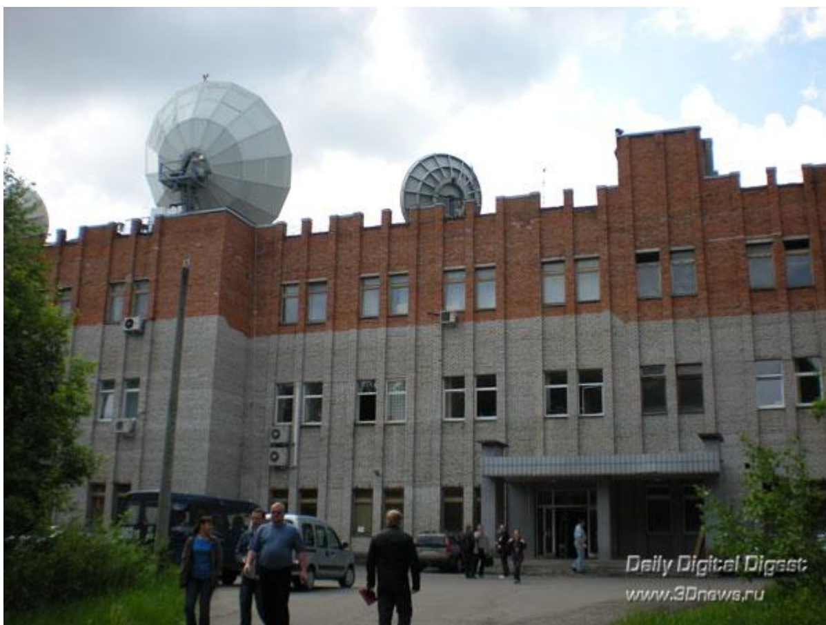
Здание "Звук" - сейчас здесь много антенн на крыше, раньше это был уникальный полигон.
